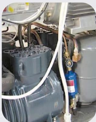
I mantecatori ECOGEL sono dotati di due impianti frigoriferi paralleli che permettono una riduzione del 20% delle potenze nominali applicate e riducono, di conseguenza, i consumi di energia e acqua. Il cilindro svuotato potrà essere mantenuto freddo tra +1°C ÷ +3°C. L'utilizzatore può sostituire i componenti di normale usura in relazione al tempo di funzionamento. Viene così garantita la longevità dei mantecatori Ecogel.
